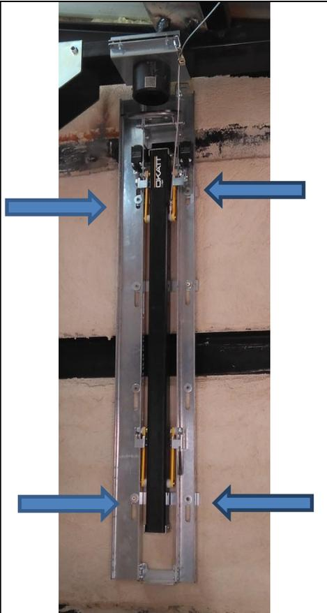
Una vez ajustado en altura se coloca en su posición y se marcan los taladros a realizar para la fijación del tope a las paredes. Los punto de fijación son:
