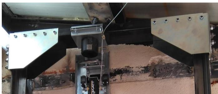
Apoyar el tubo sobre la punta de las guías, las dos puntas deben estar cortadas al mismo nivel para un correcto apoyo del tubo. Unir el conjunto formado por el tubo y las escuadras y las chapas de unión de escuadras a cada una de las guías.
